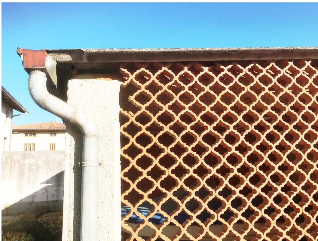
Particolare copertura in eternit della tettoia esterna
